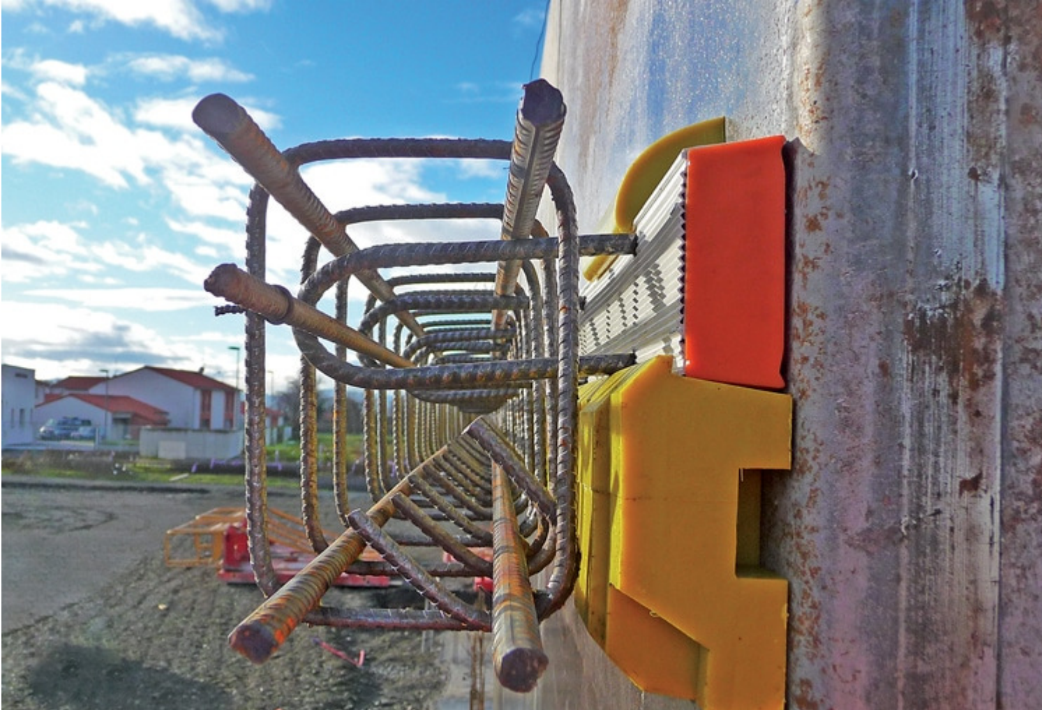
Système de boîtes d'attente du groupe Snaam avec option LVPPE. [©Groupe Snaam]
